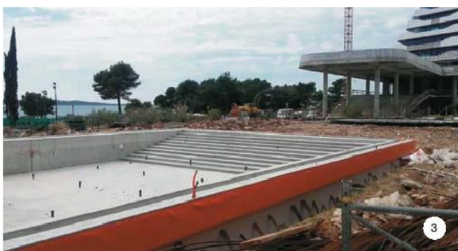
SLIKA 1: Hidroizolacija temeljne ploče sintetičkom PVC-P folijom MAPEPLAN UG 20.
