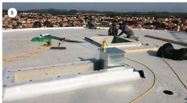
SLIKA 5: Hidroizolacija krovova sintetičkom PVC-P folijom MAPEPLAN B 15.
